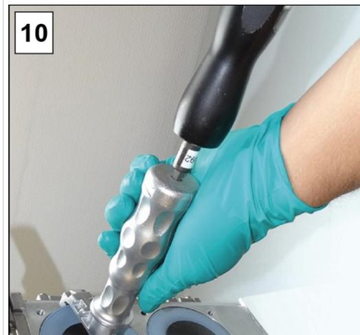
10. 然后，将带有内六角套件的扭矩扳手套到膜片用扳手上，用 6 Nm 的力矩拧紧组件。
